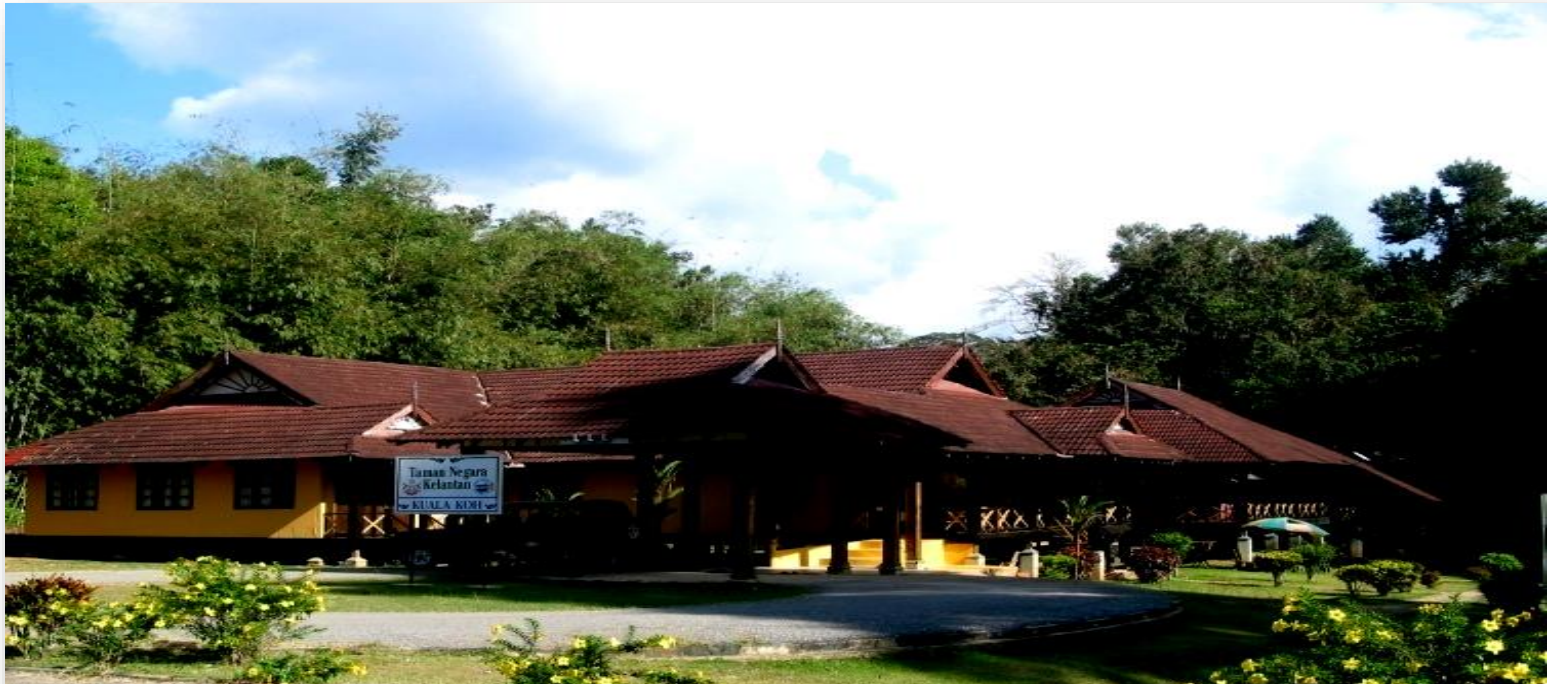
Taman Negara Kelantan, Kuala Koh office complex
